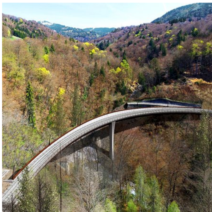
Le nouveau viaduc bénéficiera d'un dispositif de réglage.
