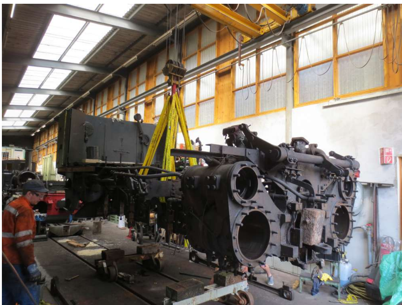
Levage du châssis HP à l'aide du palan afin de démonter les essieux.
