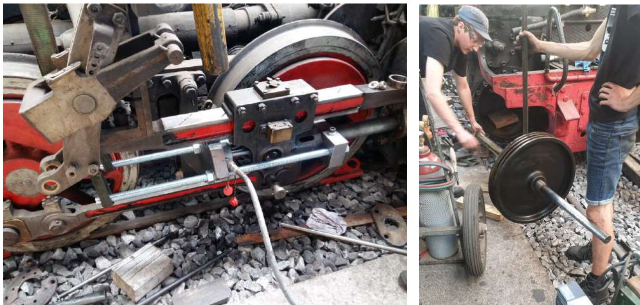
Démontage des crosses et des pistons basse pression (BP).
