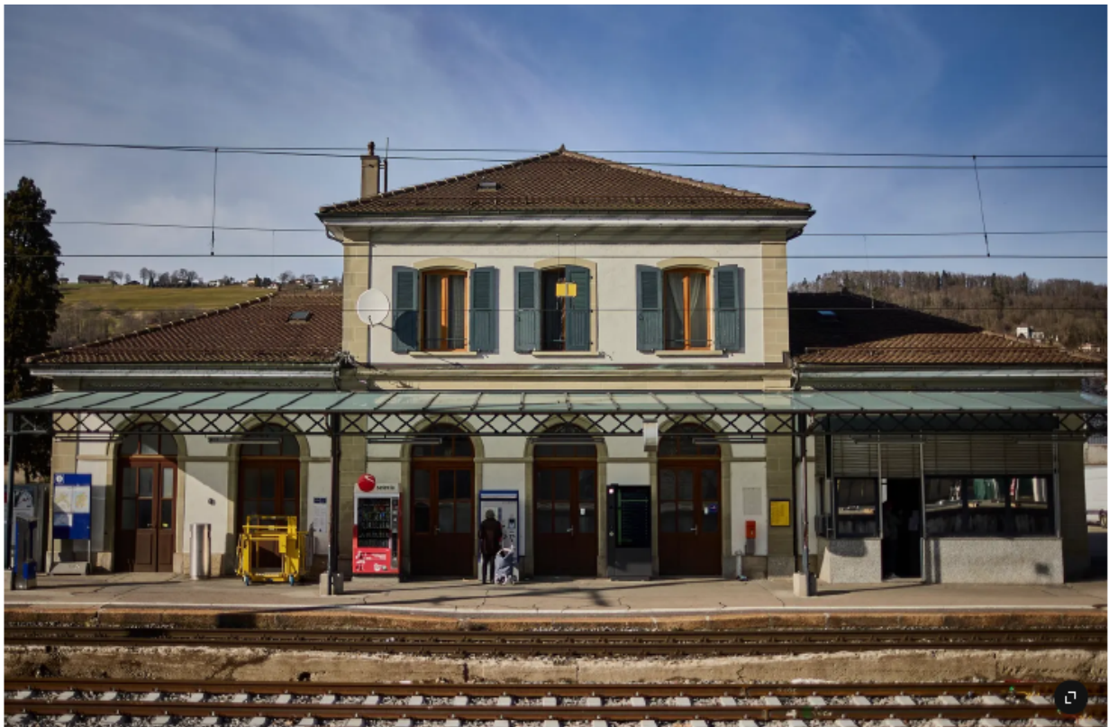
Insgesamt werden im Rahmen der Modernisierung der SBB-Strecken im Broyetal zwölf Bahnhöfe, darunter auch der Bahnhof Moudon, auf den neuesten Stand gebracht. Yvain Genevay / Tamedia
