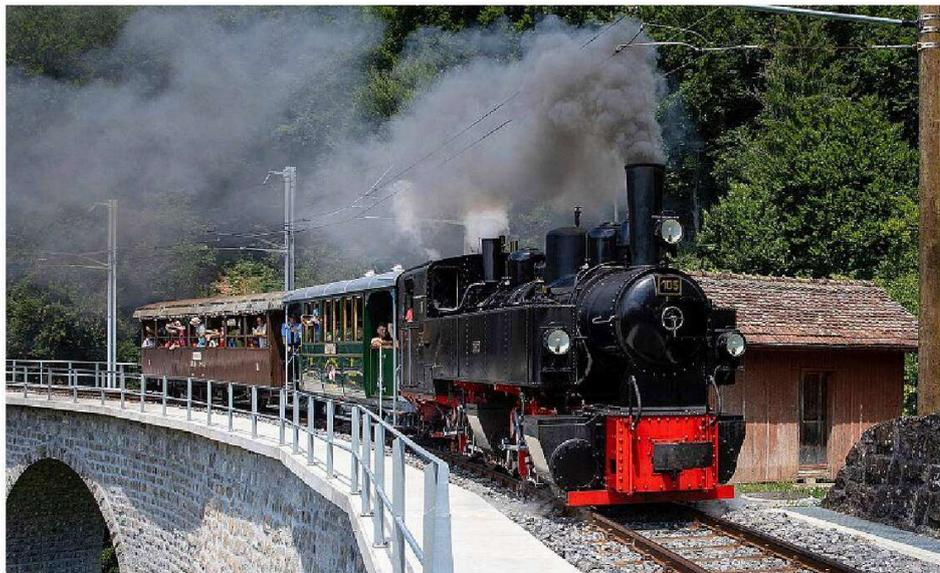
Les trains du Blonay-Chamby traversent le viaduc de la Baye de Clarens, un ouvrage en pierres de taille à six arches long de 78 mètres et surplombant de 25 mètres le torrent.
