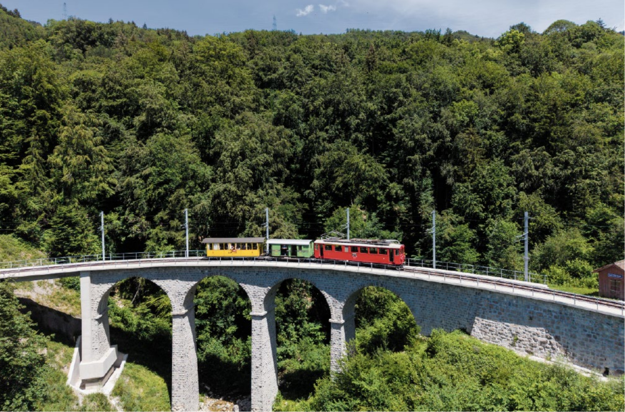
Le plat principal du menu est servi au milieu du viaduc de la Baye de Clarens, entre Blonay et Chamby (VD).
